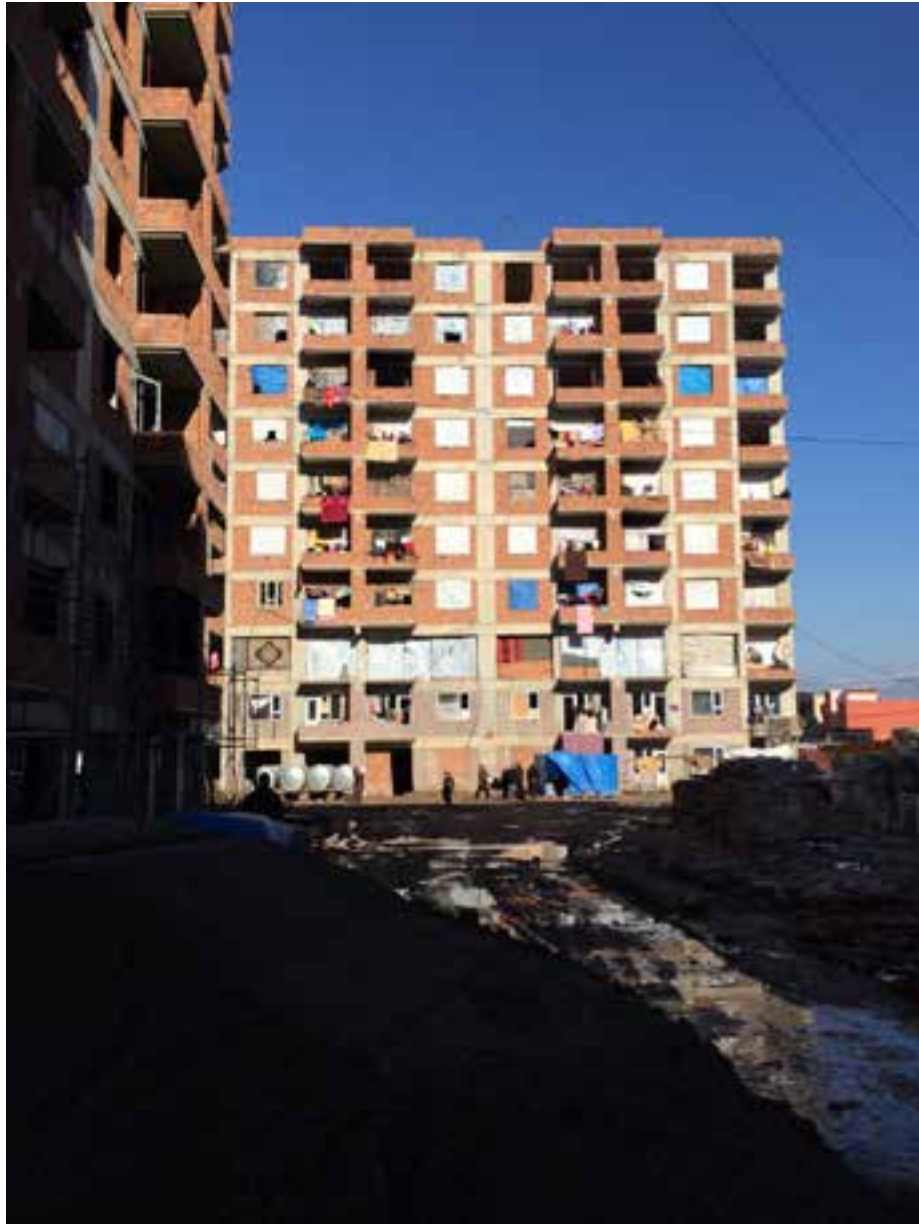
مقاطعة زاخو في محافظة دهوك. أوضاع معيشة النازحين، تشرين الثاني ٢٠١٤. الصورة: المفوضية السامية لشؤون اللاجئين، جوزيف ميركس
